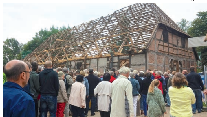
Großer Andrang auf dem Bauhofareal. Im Fokus des Interesses: Die beiden Torhäuser. Fotos: Hasse
